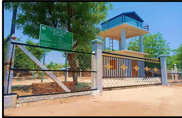
ပခုက္ကူမြို့နယ်၊ ချောင်းဆုံကျေးရွာ တွင်းနက်တူးဖော်ခြင်းလုပ်ငန်း
