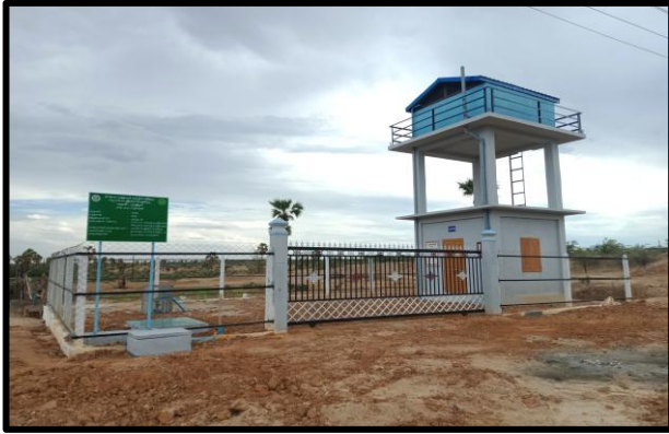
ပခုက္ကူမြို့နယ်၊ ဆုံကုန်းကျေးရွာ၊ တွင်းနက်တူးဖော်ခြင်းလုပ်ငန်း
