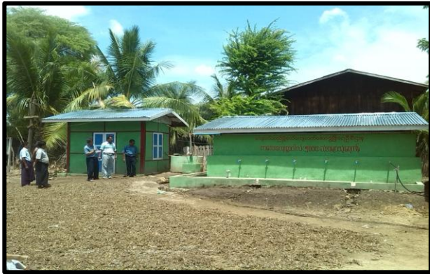
ကျောက်ဆည်မြို့နယ်၊ကလေးကျေးရွာ၊ အုတ်ရေကန်တည်ဆောက်ခြင်းလုပ်ငန်း
