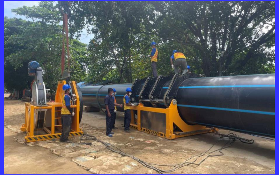
1600 mm \phi HDPE ပိုက်လိုင်း အရှည် ၃.၂ မိုင် ဆက်သွယ်ခြင်းလုပ်ငန်း ဆောင်ရွက်မှု မှတ်တမ်းများ
