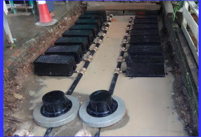
ရေဖြန့်ဖြူးပေးဝေရေးပိုက်လိုင်း Distribution Pipe-DMA ကွန်ရက်နှင့် အိမ်သွယ်ပိုက်ဆက်သွယ်ခြင်းလုပ်ငန်းဆောင်ရွက်မှု
