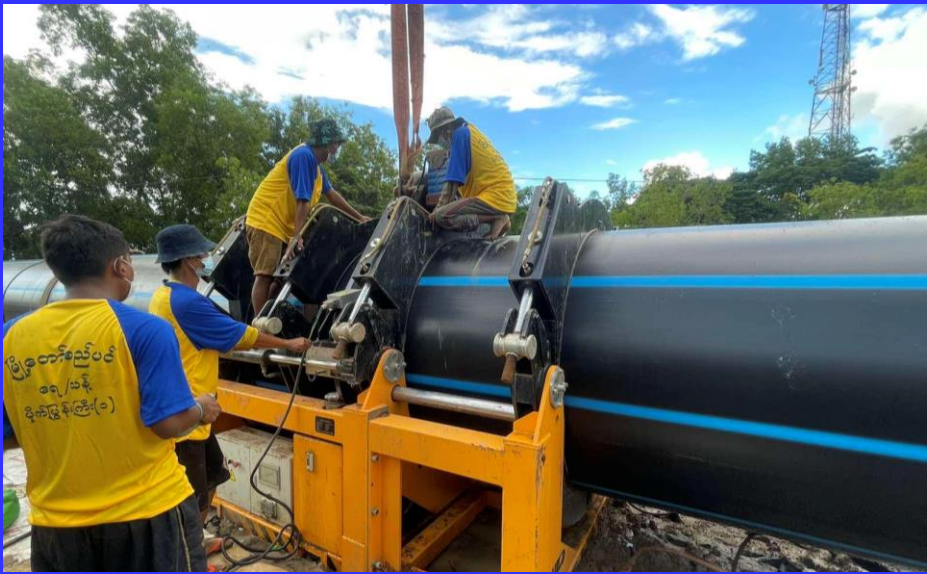
1600 mm \phi HDPE ပိုက်လိုင်း အရှည် ၃.၂ မိုင် ဆက်သွယ်ခြင်းလုပ်ငန်း ဆောင်ရွက်မှု မှတ်တမ်းများ
