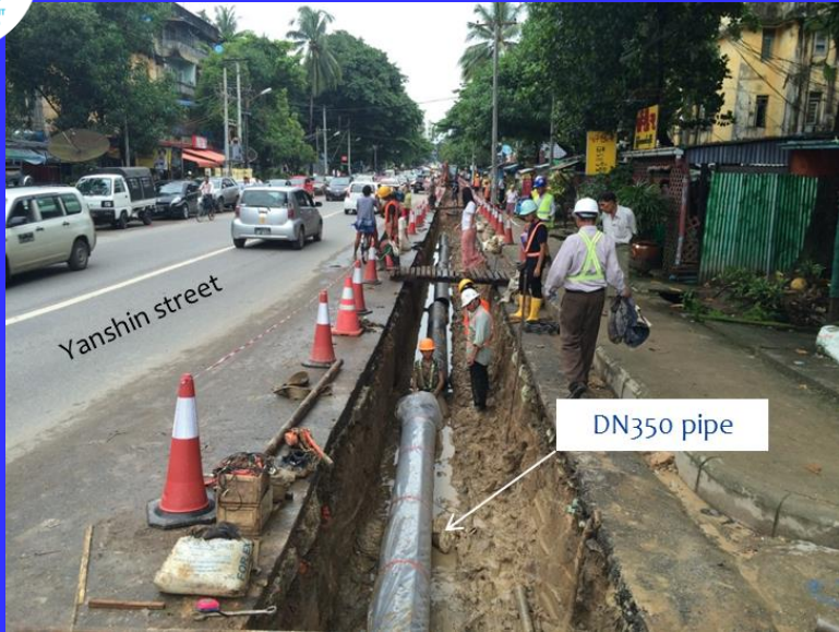
ရေဖြန့်ဖြူးပေးဝေရေးပိုက်လိုင်း Distribution Pipe-DMA ကွန်ရက်နှင့် အိမ်သွယ်ပိုက်ဆက်သွယ်ခြင်းလုပ်ငန်းဆောင်ရွက်မှု
