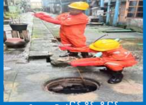
Sewer Rod ဖြင့်လိုင်းထိုးခြင်း
