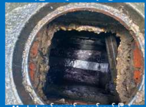
Manholeတွင်းအနည်များရှင်းလင်းပြီးပုံ
