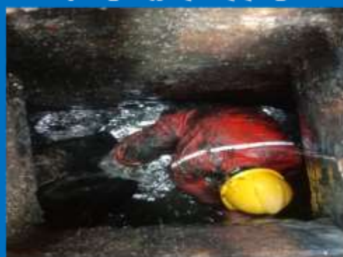
Manholeတွင်းဆင်း၍အနည်ဆယ်ခြင်း/လိုင်းထိုးခြင်း
