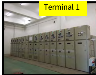
12kV Switchgears Siemen, SIMOPRIME Hainam, Vietnam
